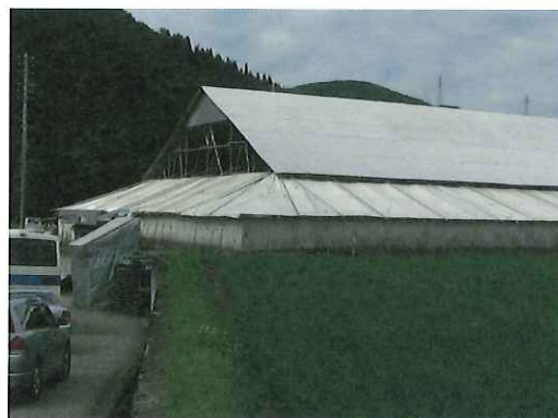
図3 グリーンファームの雪中貯蔵施設 (新潟県魚沼市)
