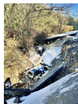
耐震水道管が破断 (輪島市)
